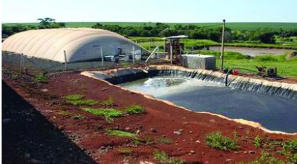
**Figura 4. Biodigestor do tipo canadense ou de fluxo tubular.**
